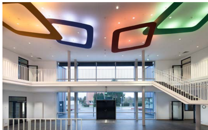
Abb: Die Leuchten werden durch dynamisch geformte, farbige Holzrahmen ergänzt und in verschiedene Richtungen gedreht. So wird die Anmutung eines »Schwarms« unterstützt und das Licht farbig an die Decke reflektiert.
