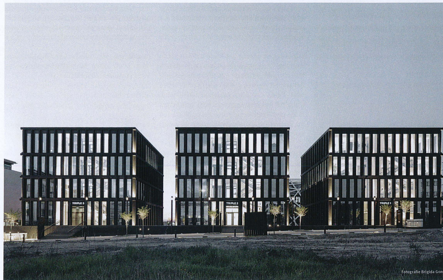
Die Lichtpunkthöhen sind immer gleich – ganz unabhängig vom Geländeverlauf. Die Innen- und Außenbeleuchtung wurde stimmig aufeinander abgestimmt und bilden
