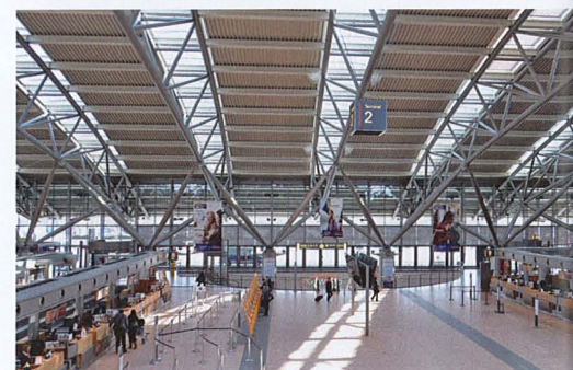
Die intelligente Sonnenschutzlösung im Terminal des Hamburger Flughafens verhindert die Blendung an den Arbeitsplätzen, ohne die Tageslichtqualität inklusive des atmosphärischen Sonnenlichtanteils dauerhaft zu verlieren. Foto: Peter Andres Lichtplanung
