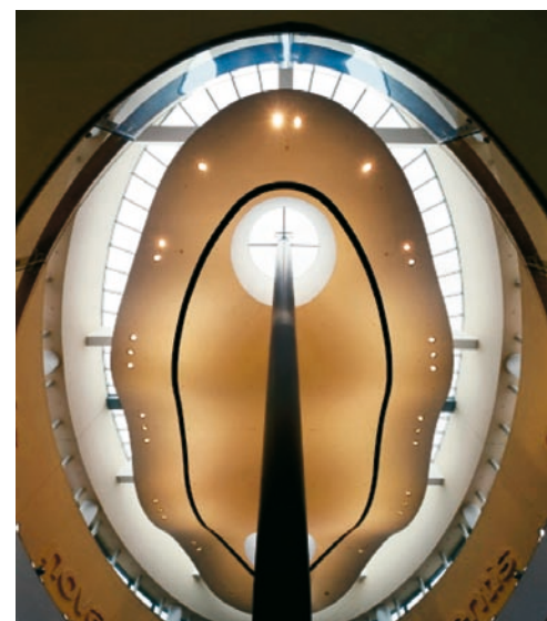
Blick auf die Deckenuntersicht der kleinen Event-Mall
