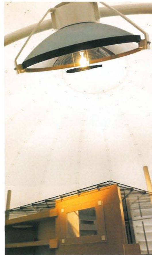
Mehr als 1000 Leuchtstofflampen erzeugen das diffuse Licht des künstlichen Himmels
