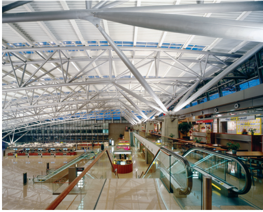
2 Komplett indirekte Beleuchtung
