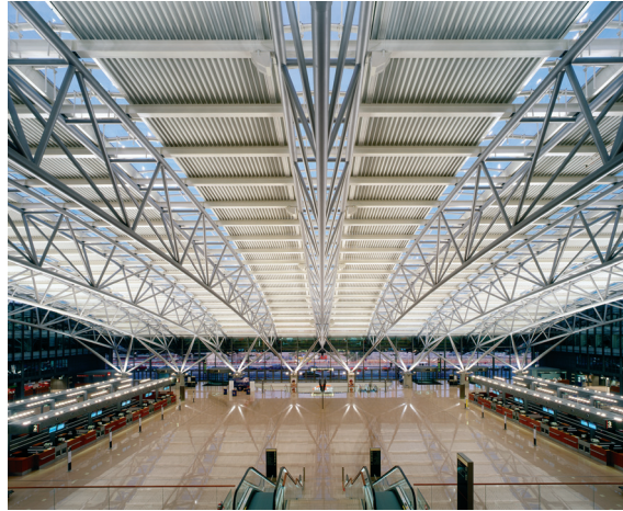
1 Zentrale Halle des Terminals
