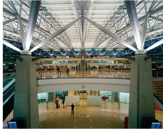
3 Betonstützen mit Doppelfunktion
