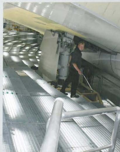
Airbus Lackierhalle A380, Architekt: Pysall, Stahrenberg + Partner Fotos: Airbus
