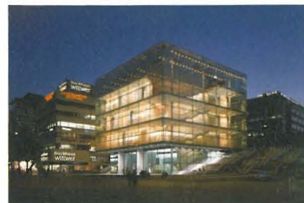
Kunstmuseum Stuttgart, Architekten: Hascher, Jehle + Assoziierte, Fertigstellung 2005
