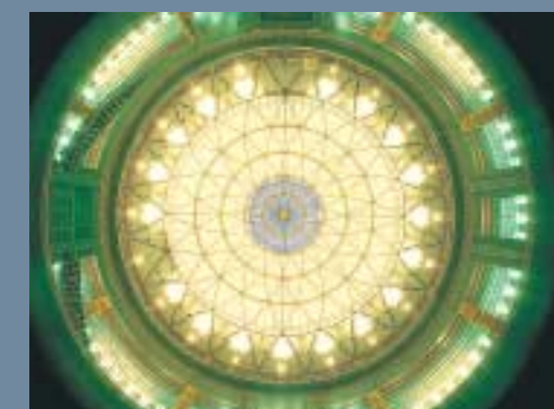
Blick in die Lichtkuppel: bei Tag erscheint sie durchsichtig, in der Nacht bewirkt der Einsatz von mattiertem Glas, dass das auftreffende Kunstlicht reflektiert wird. Nur die beiden mittleren Ringe, die mit Klarglas belegt sind, bleiben durchsichtig
