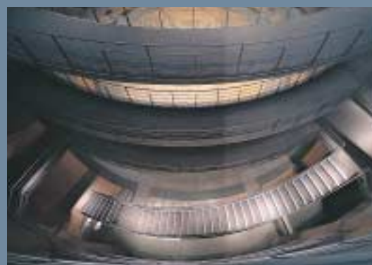
Die Treppe wird vom Dachgeschoss aus mit engstrahlenden Lichtsystemen erhellt
