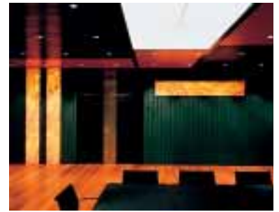
DG Bank, Hannover. Diffus strahlende textile Lichtdecke, hinterleuchtete Marmorscheiben und direkt strahlende Downlights ergeben konstante Licht- qualität unabhängig von der Möblierungs- anordnung. Foto: Heiner Leiska
